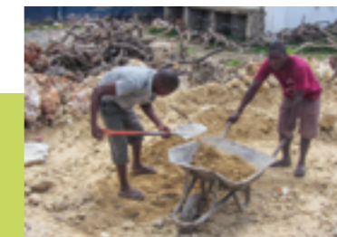
2020 . Baustart des Dormitoriums.
