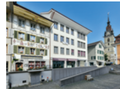
▼ Die historische Aussenfassade nach der Totalsanierung.
