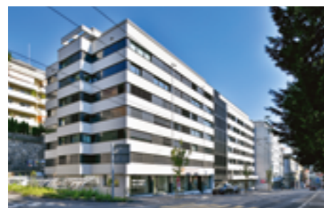
▲ Umbau Wesemlinstrasse, Luzern
