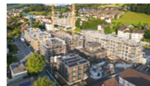
▲ Überbauung St. Klemens, Ebikon: die Solaranlage, welche auf den Dächern montiert wird, wird ein Teil der benötigten Energie selber produzieren.
