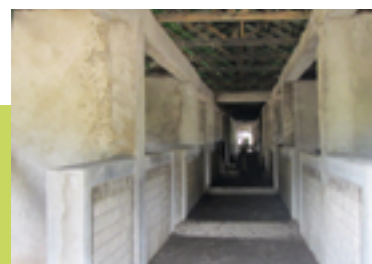
Etwas weiter gediehener Rohbau. Nach langem Hin und Her hat sich Baupolier Paul Mwaura durchgesetzt: Die bis zur Decke hochgezogenen Seitenwände verleihen den Schlafabteilen doch eine gewisse Geschlossenheit. Türen sind keine vorgesehen.
