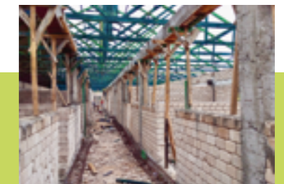
Die Mauern der Schlafabteile beidseits des Korridors dürften gemäss staatlicher Vorgaben nicht höher sein als 150 cm, um die Aufsicht der Mädchen zu gewährleisten. Die Dachträger sind vor dem Einbau mit einer grünen Chemikalie gegen Termitenfrass behandelt worden.
