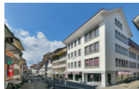
▲ Umbau Vordere Hauptgasse 33, Zofingen
