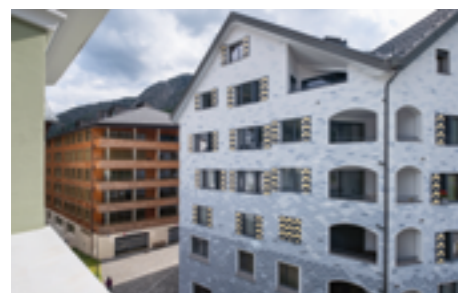
▲ Neubau Apartmenthäuser Wolf und Edelweiss, Andermatt
