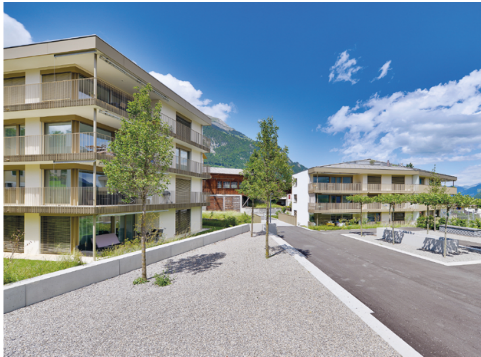
▲ Neubau Wohnüberbauung Schoried, Alpnach
