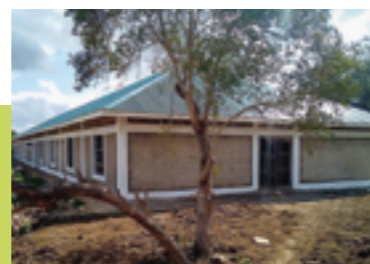
2021 . Fertigstellung des Dormitoriums mit 234 Schlafplätzen.
